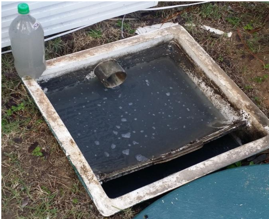
Figura 3: Ponto de coleta da água cinza clara comercial Fonte: Núcleo de Bioengenharia Aplicada ao Saneamento UFES
