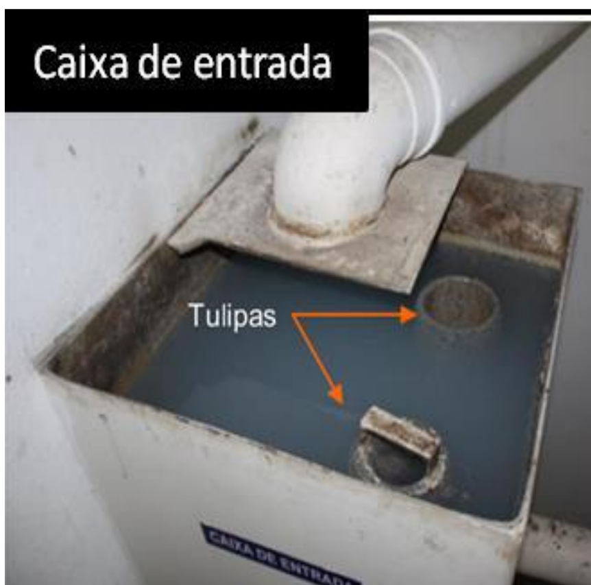
Figura 1: Ponto de coleta da água cinza clara residencial Fonte: Núcleo de Bioengenharia Aplicada ao Saneamento UFES.
