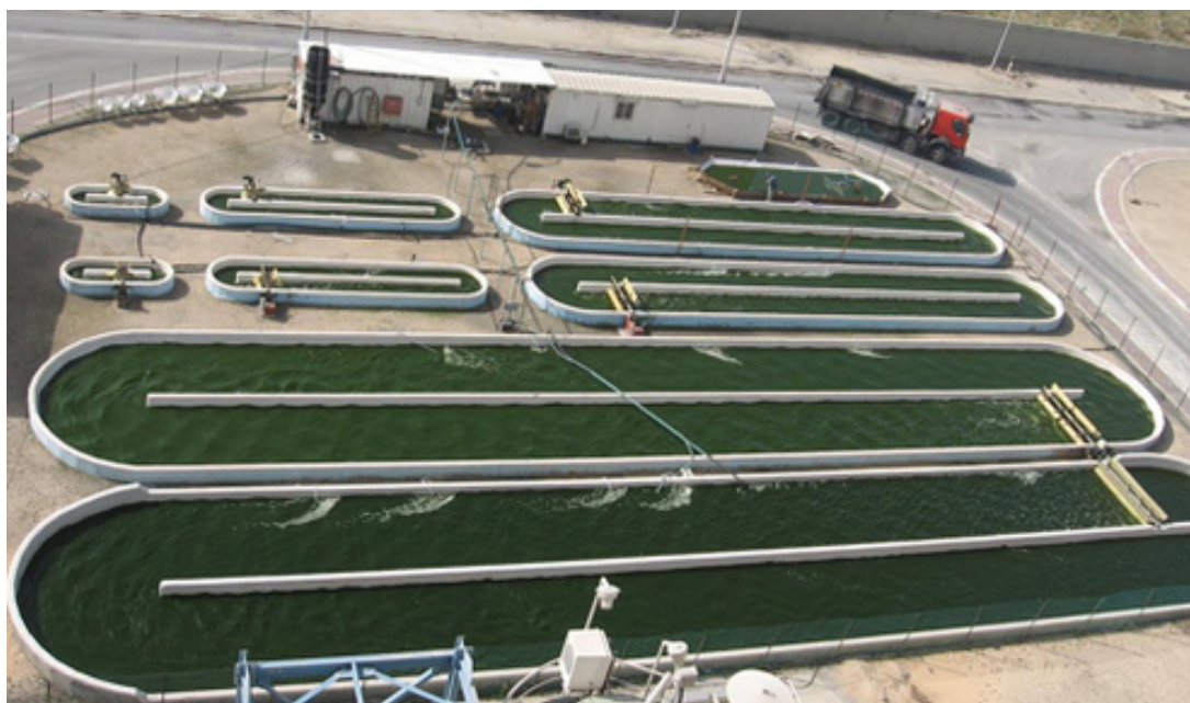
Figura 3: Planta piloto para geração de biocombustível de microalgas em um fotobiorreator modelo Raceway– Israel.
