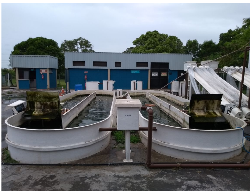
Figura 1: Modelo Raceway – Estação piloto de tratamento de esgoto integrado ao cultivo de microalgas, Araçás, Vila Velha.
