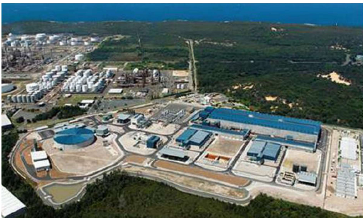
Figura 19: Vista aérea da planta de dessalinização de Sydney, Austrália.
