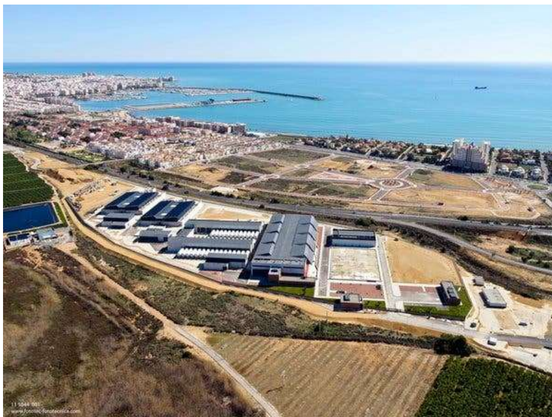
Figura 18: Vista aérea da planta de dessalinização de Torevieja, Espanha.
